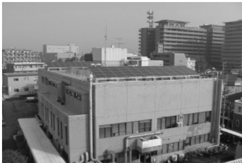
上下水道局別館
