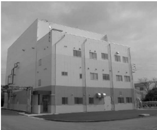
固形燃料化施設
